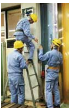
取り付け作業風景
